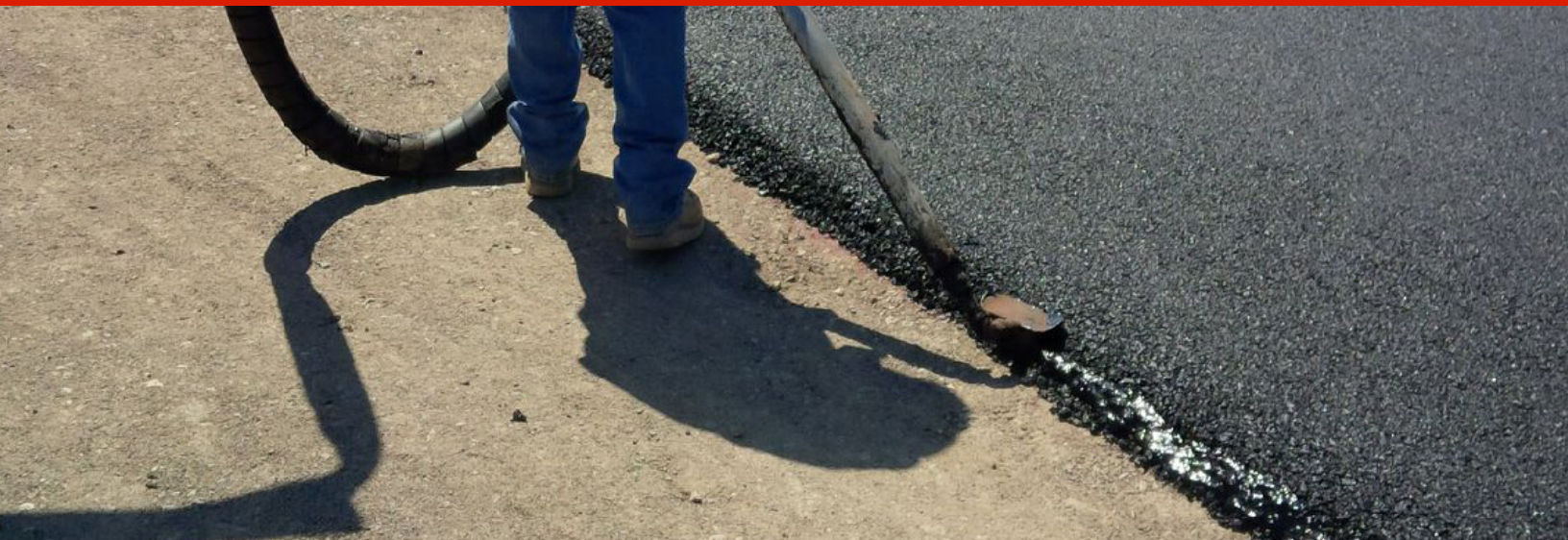
Aplicación de la junta fría de pavimento
